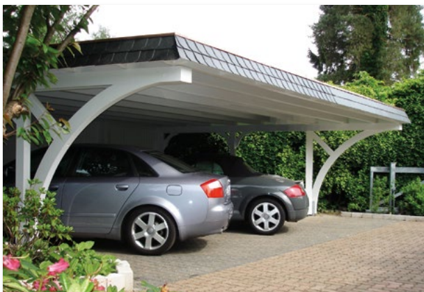
Optische Leichtigkeit erzielt dank spezielle Segmentbögen.
