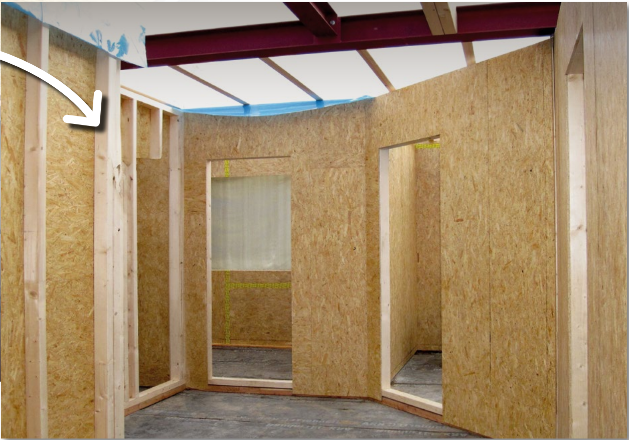
Vorgefertigte Wandelemente auf der Baustelle
