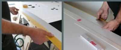
**Plattenstoß:** Um gleichmäßigen Plattenübergang am Stoß zu gewährleisten, wird empfohlen Plattenstoßschiene mit DS-Klebeband rückseitig an der Außenkante zu befestigen.
