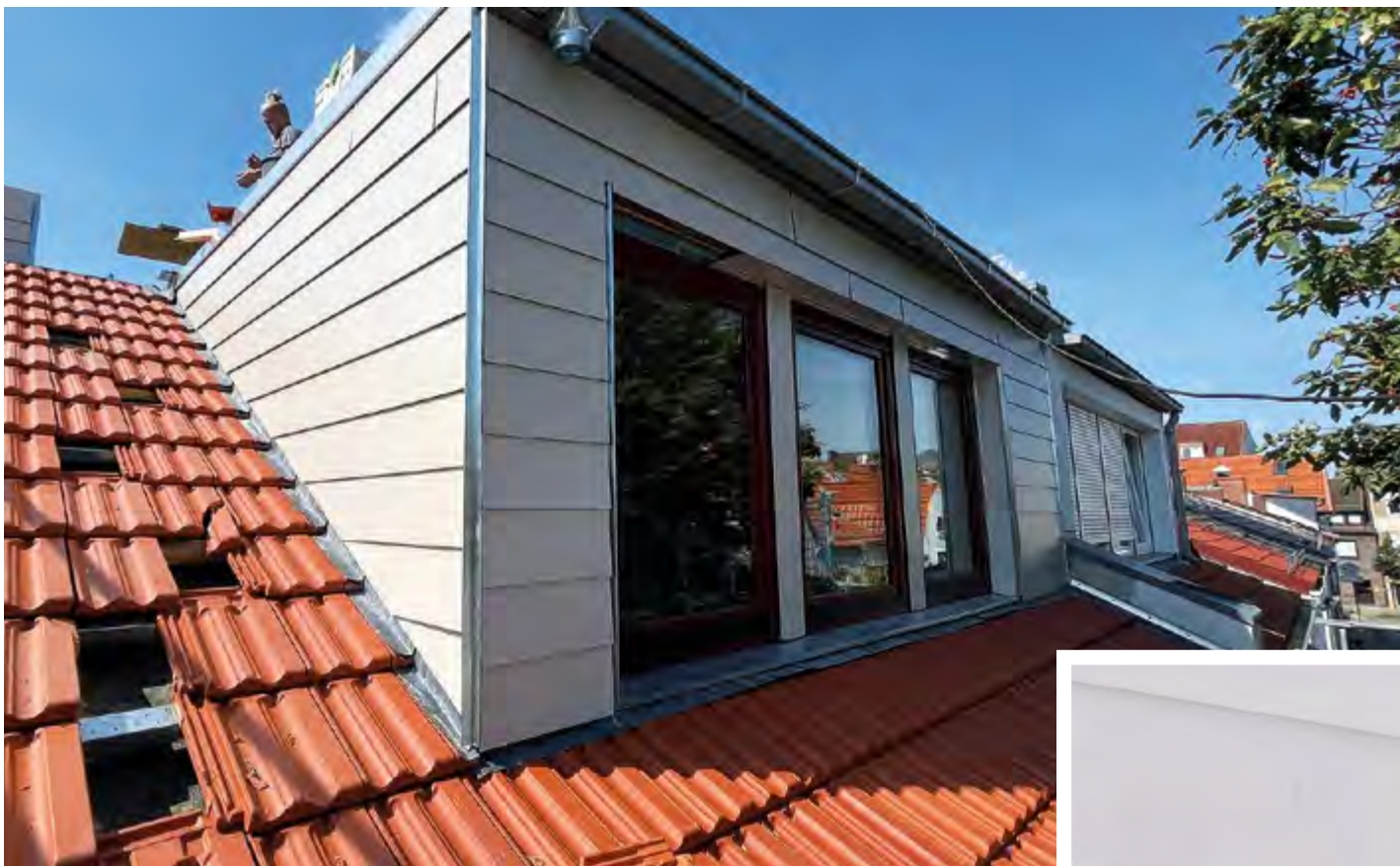
Wenn alle Vorgaben stimmen, ist die passgenaue Montage problemlos und schnell erledigt.
