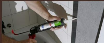
Plattenanbau: Platte für Platte zuschneiden, prüfen und anpassen. Vor dem endgültigen Ansetzen Silikon an der Stoßfuge aufbringen.
