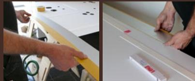
Plattenstoß: Um gleichmäßigen Plattenübergang am Stoß zu gewährleisten, wird empfohlen Plattenstoßschiene mit DS-Klebeband rückseitig an Außenkante zu befestigen.
