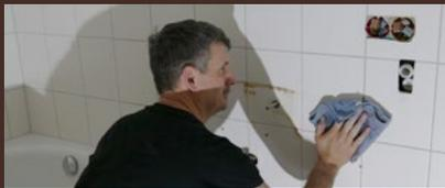
Überprüfen der bautechnischen Voraussetzungen: Untergrund muss ausreichend tragfähig, eben und trocken sein. Stark saugende Untergründe müssen vorbehandelt werden.
