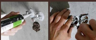
Öffnungen schließen: Mit Silikon alle Öffnungen ausspritzen und danach Armaturen montieren.
