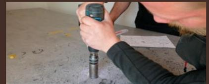
Bohren: Löcher für Armaturen am besten mit feinzahnigen Lochkreisschneider in entsprechendem Durchmesser vornehmen.
