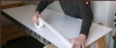
DS-Klebeband anbringen: Schutzfolie auf Rückseite abziehen. Zur Anfangshaftung der Platten, 2 mm dickes Schaumstoffklebeband streifenförmig und um Armaturbohrungen aufkleben.
