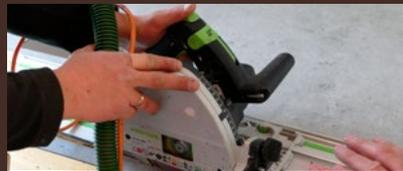
Zuschnitt: Für gerade Schnitte am besten mittels Führungsschiene und feinzahnigen, hartmetallbestückten Handkreissäge verwenden. TIPP: Ausschnitte vorbohren und mit feinzahniger Stichsäge aussägen.
