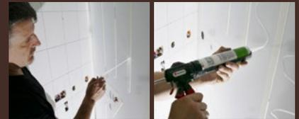
Vor Verklebung: Schutzfolie des Schaumstoffdoppelklebebands abziehen. Zum Verkleben, hochwertiges essigfrei vernetzendes Neutral Silikon rückseitig auf Platte aufbringen.
