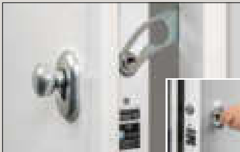
Sperrbügel von innen und außen zu bedienen
