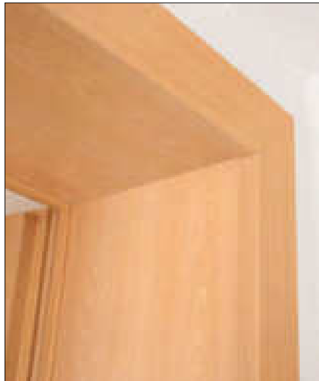
Blendrahmen mit Laibungsverkleidung
