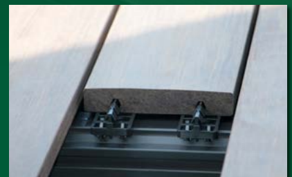
Montage ohne Vorbohren und Schrauben, keine Rissbildung
