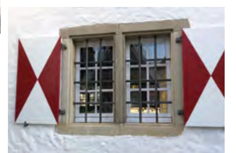
Die neuen Fensterläden
